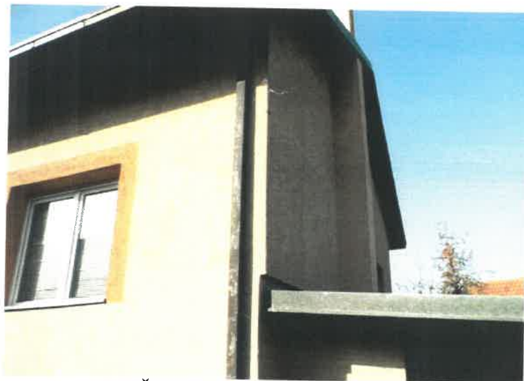
DESNA BOČNA-SEVERNA FASADA OBJEKTA
