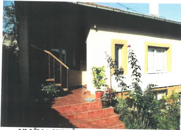
ULIČNA-ISTOČNA FASADA OBJEKTA
